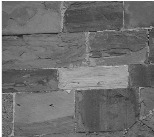
Il paramento in arenaria - dettaglio
